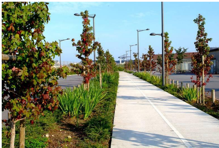
Réalisation de voirie avec noues plantées attenantes Source : Banque photo INFRA Services
